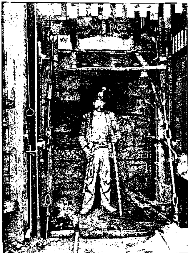
“Mölnard” lähdössä nostolavalla alas satojen jatkojen syvyyteen. Huomaa lamppu otsassa ja porat käsissä.
