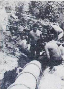
Favelados instalam exgoto em mutirão
