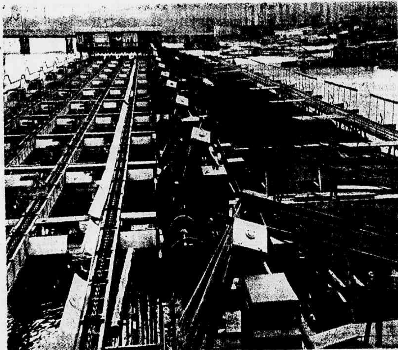
AUTOMATIZAÇÃO — Novas linhas automáticas são instaladas constantemente na União Soviética. A que vemos nesta foto (Agência TASS) foi produzida em Leningrado. Seu comprimento é de 128 metros, por 20 de largura. Esta unidade pode elaborar 1.600 metros cúbicos de madeira em cada movimento.
